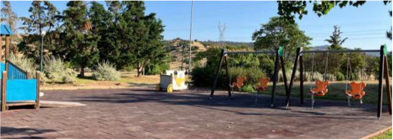
Εικόνα 1 Δάπεδο Παιδικής Χαράς προς αντικατάσταση (Τμήμα Β)
