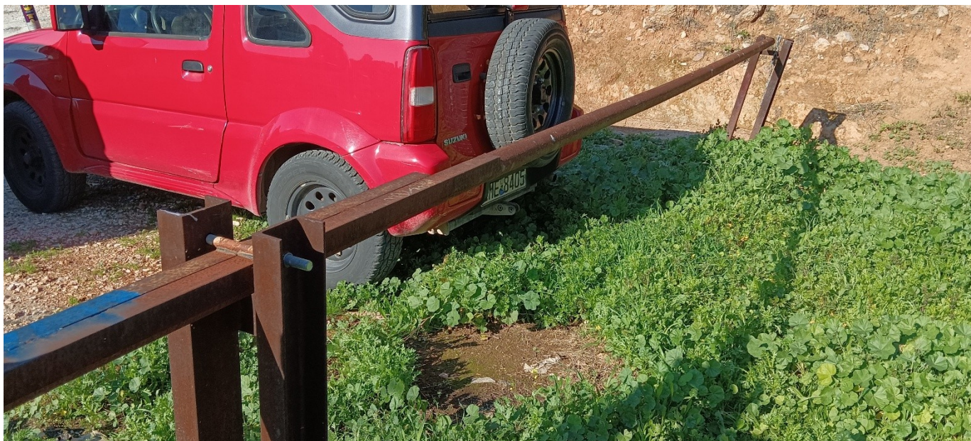
Ένδειξη μπάρας που χρήζει συντήρησης
