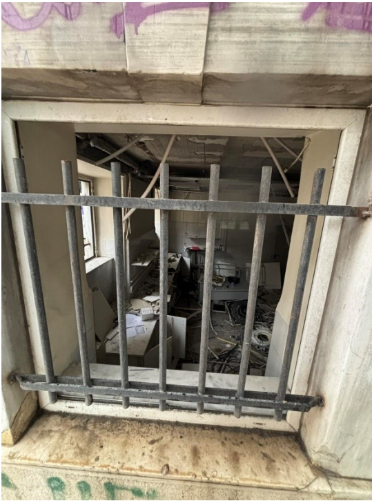
Αφαίρεση αλουμινίων και σιδεριάς από κουφώματα υπογείου επί της οδού Αγησιλάου 9
