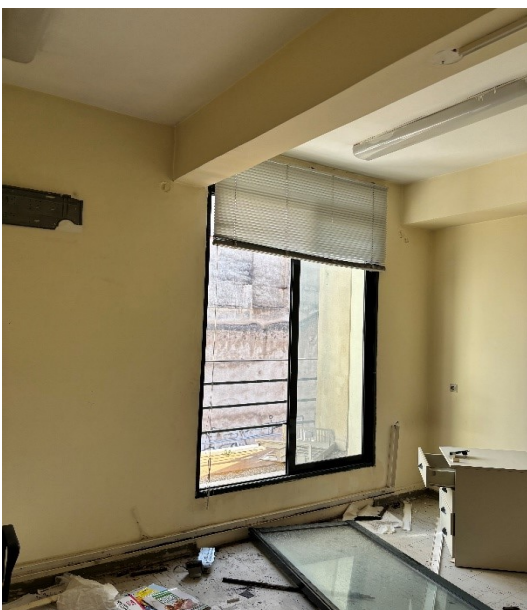
Αφαίρεση κουφωμάτων αλουμινίου στον 1 ο όροφο του κτιρίου προς τη ΒΑ πλευρά αυτού
