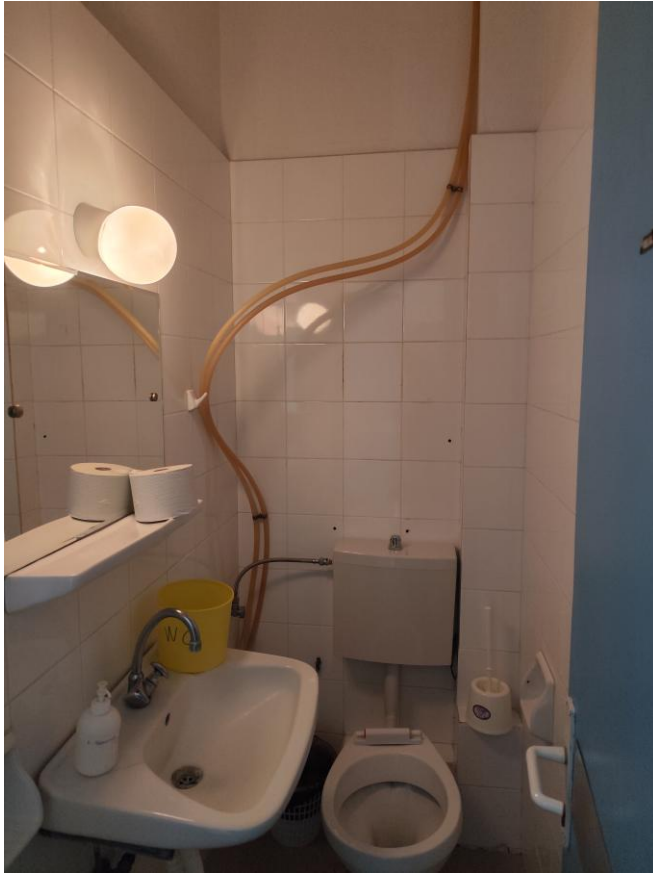
Εικόνα 5. WC του 2 ου ορόφου
