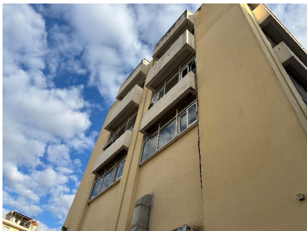
Πρεβάζια στην πίσω όψη του κτηρίου
