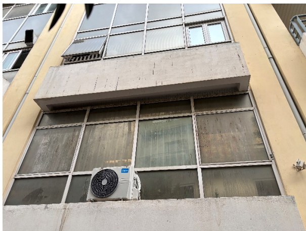
Μπαλκόνια – πρεβάζια στην πλαϊνή όψη του κτηρίου
