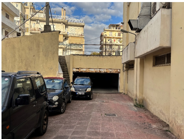
Πρεβάζια στην πίσω όψη του κτηρίου
