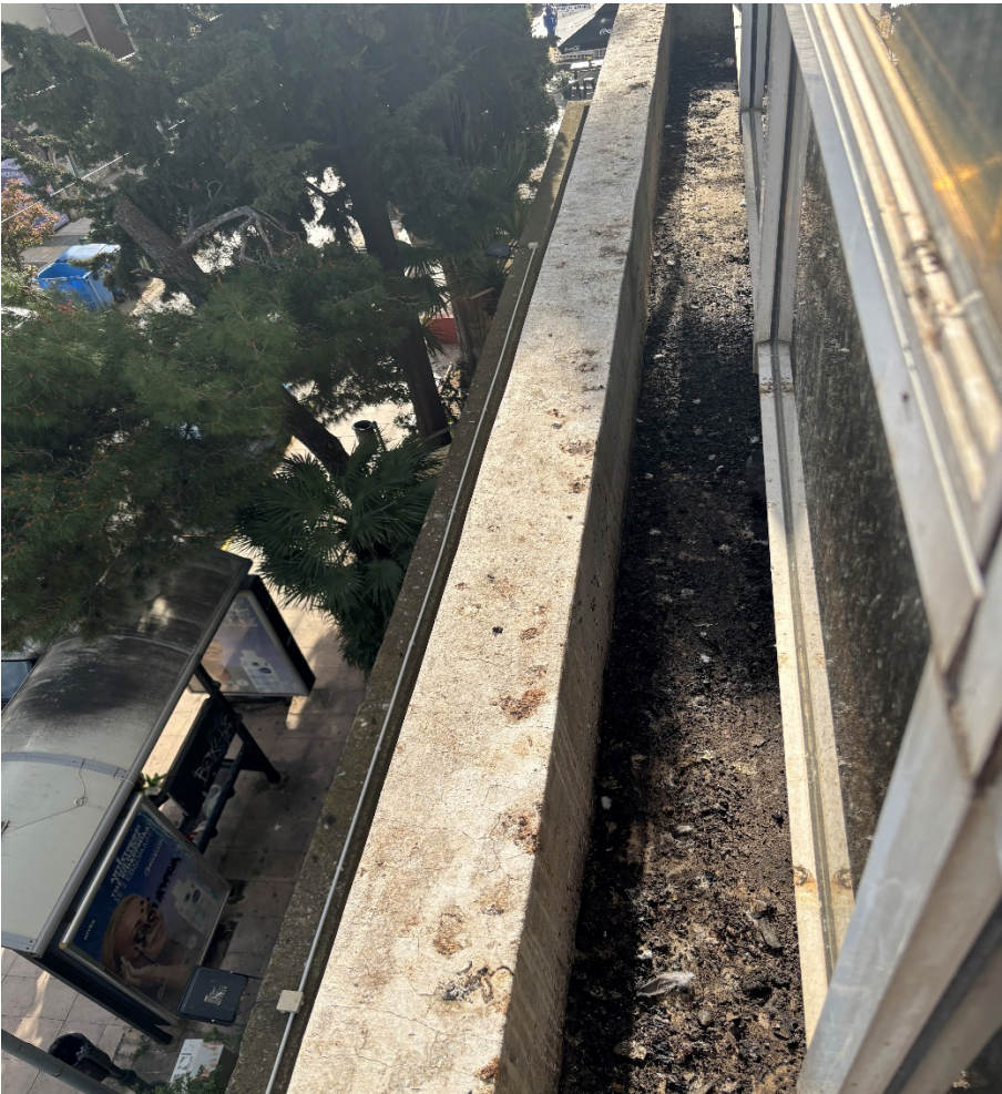
Μπαλκόνια – προβάζια στην όψη του κτηρίου επί της οδού Χατζηαντωνίου 15
