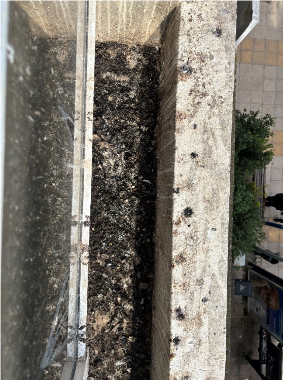
Μπαλκόνια – πρεβάζια στην όψη του κτηρίου επί της οδού Χατζηαντωνίου 15
