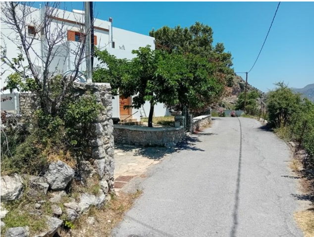
Εικόνα 1: τμήμα της οδού κατασκευασμένο από άσφαλτο
