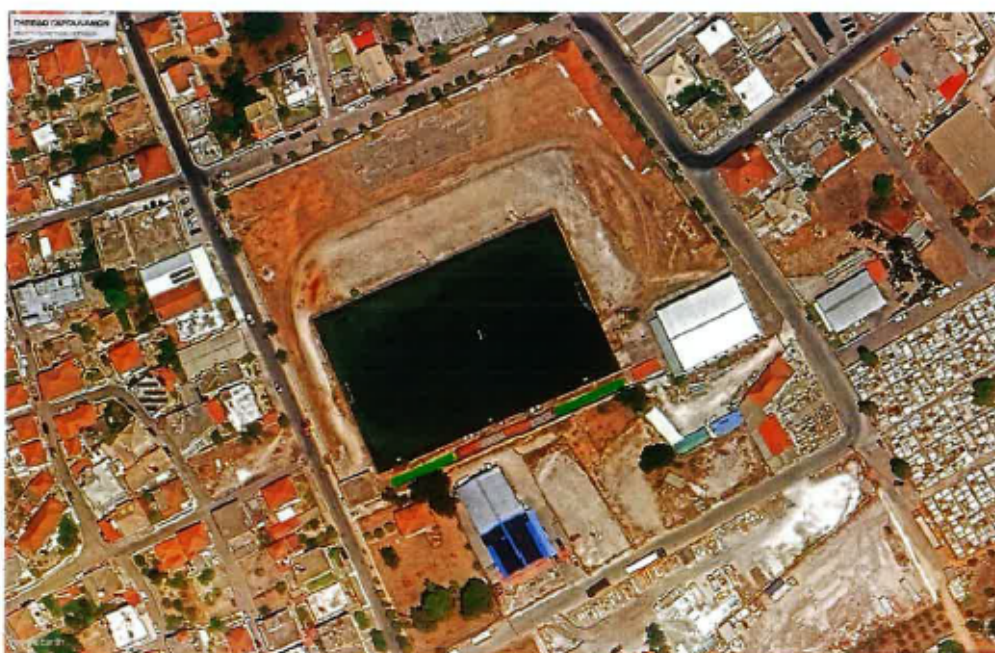
Θέση υλοποίησης έργου: Γήπεδο Γαργαλιάνων, Δήμου Τριφυλίας
