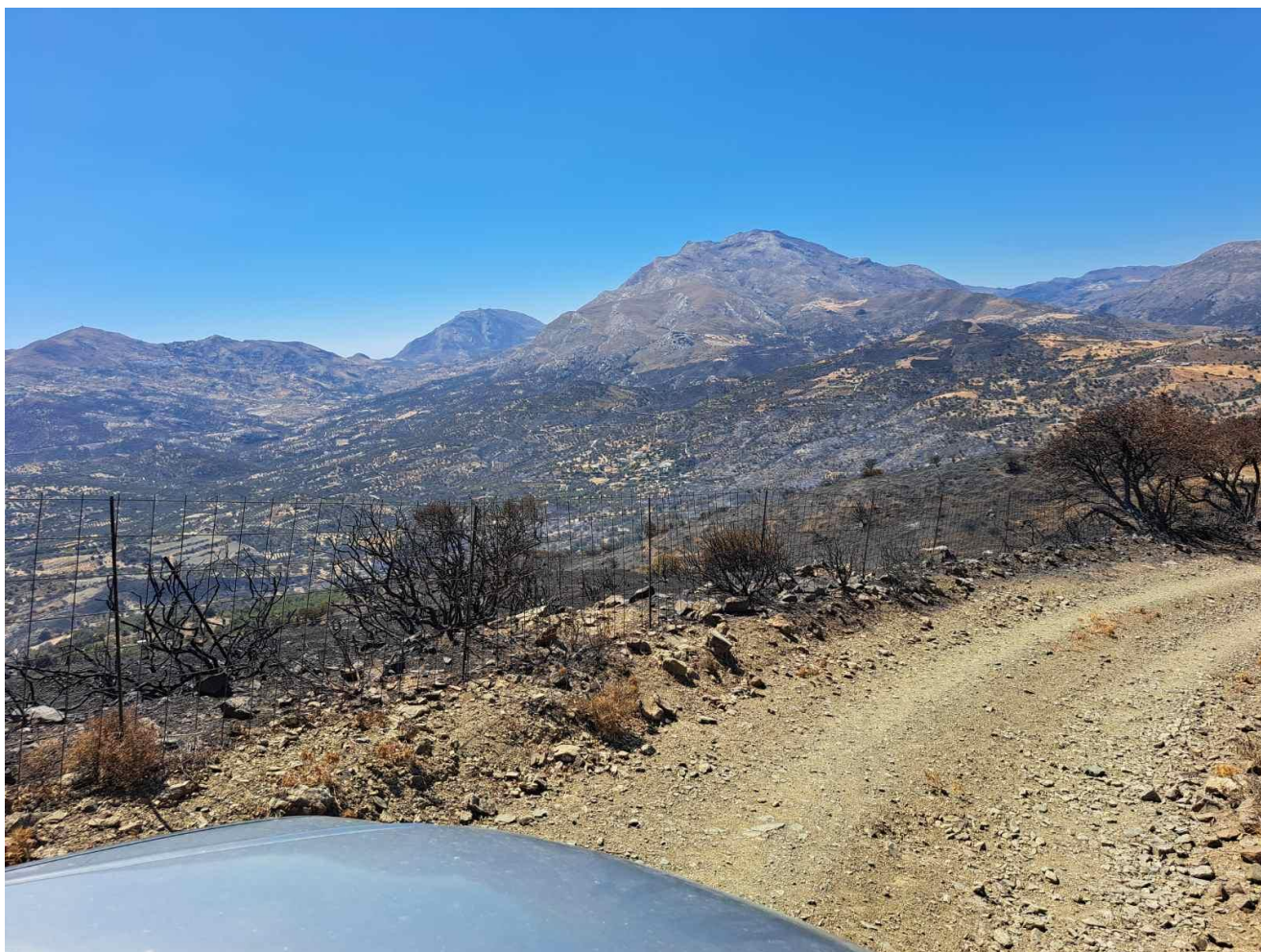
Φωτογραφία 4: Υφιστάμενη κατάσταση περιφερειακής οδού
