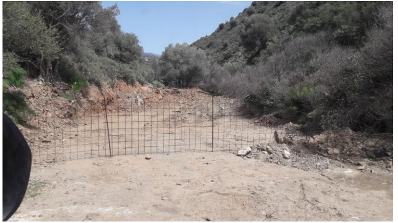
Φωτογραφία 7, 8: Θέσεις κατασκευής δεξαμενών
