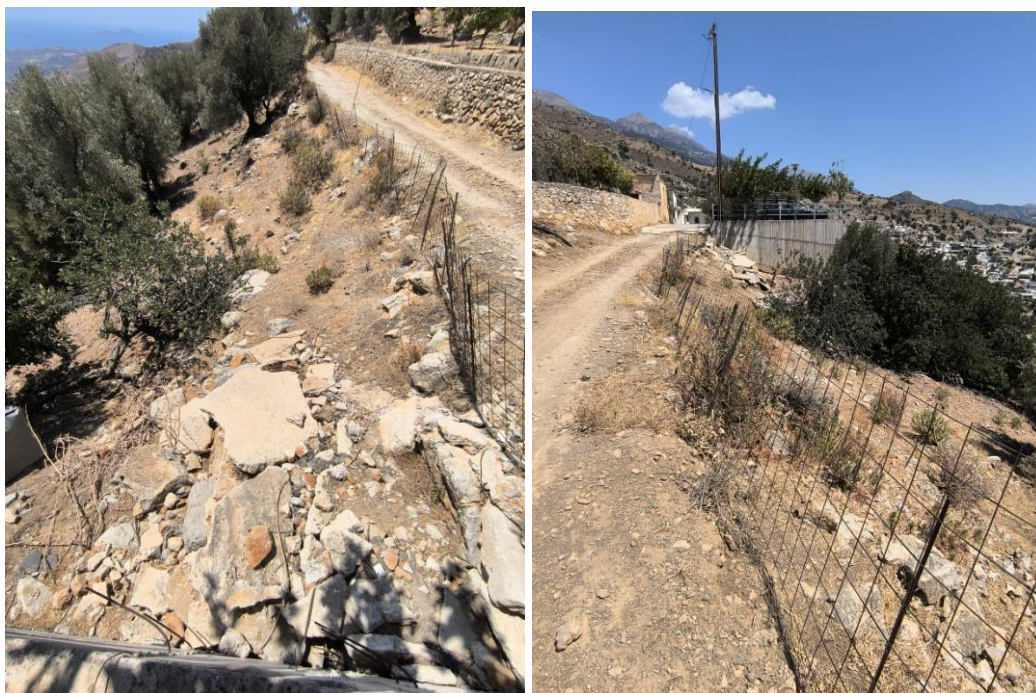
Φωτογραφία 5, 6: Υφιστάμενη κατάσταση (περιοχή «Πατρίτα»)
