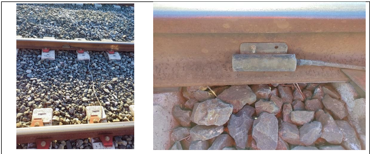
Εικόνα 90: Πυκνωτές Κυκλωμάτων Γραμμής- Φίλτρα αντιστάθμισης 30-32μF
