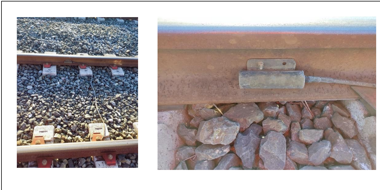
Εικόνα 17: Πυκνωτές Κυκλωμάτων Γραμμής- Φίλτρα αντιστάθμισης 30-32μF
