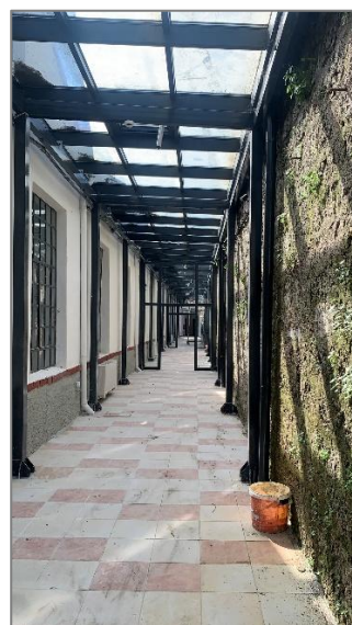
Εικόνα 5. Στοά - Ανοιχτός χώρος Workshop
