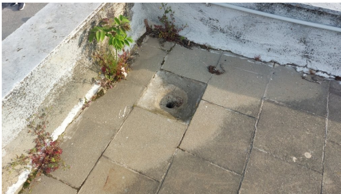
Εικόνα 6 . Δώμα του Φυλακίου (υφιστάμενες υδρορροές που θα επισφραγιστούν)
