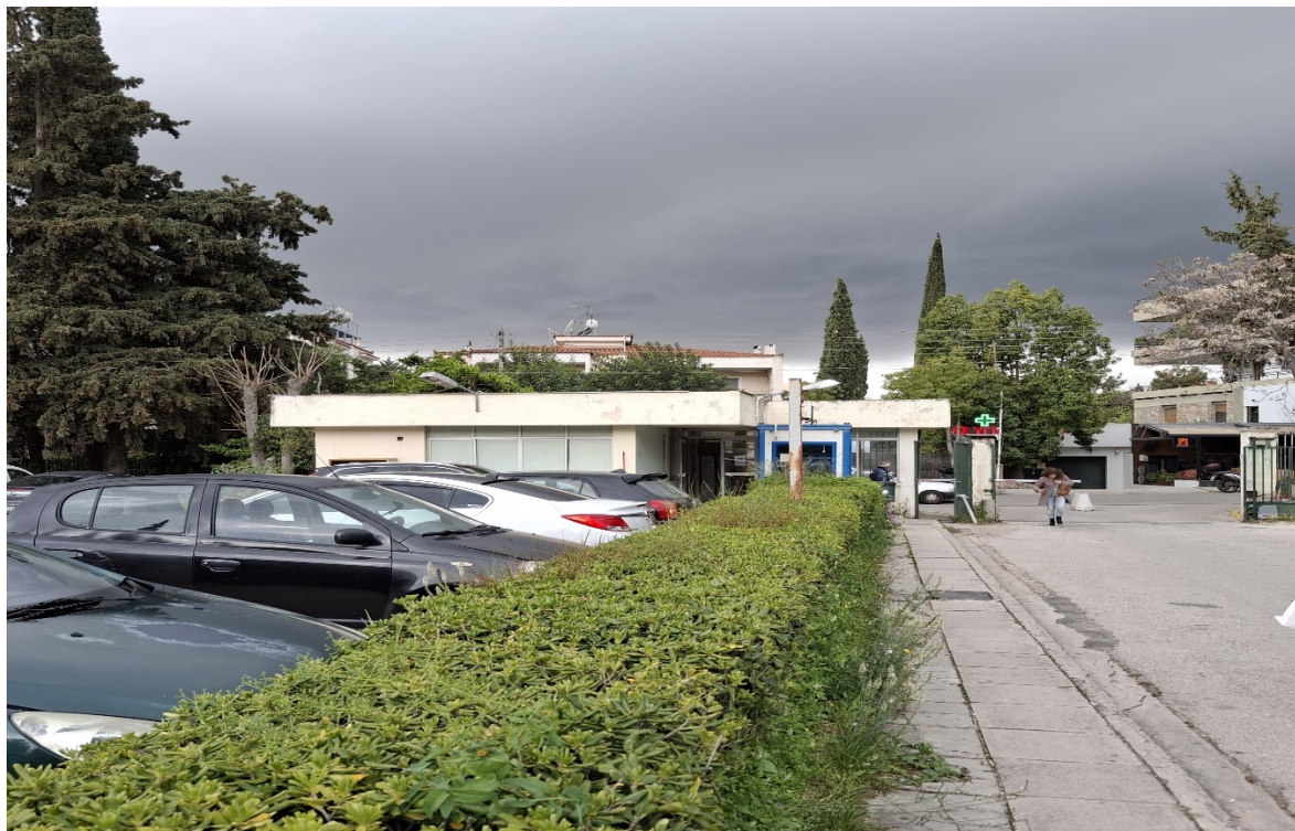
Εικόνα 4 . Ανατολική όψη του Φυλακίου
