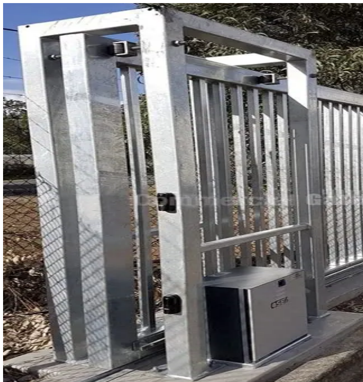
Εικόνα 7. Διπλό μεταλλικό πλαίσιο στήριξης (ενδεικτική φωτογραφία)
