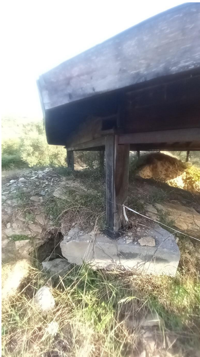
Εικ. 7.: Διαβρωμένο υπόβαθρο μίας εκ των βάσεων από μπετόν έδρασης των υποστυλωμάτων του στεγάστρου
