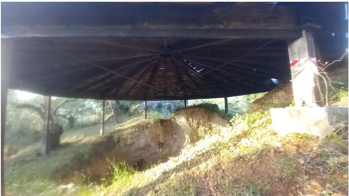
Εικ. 4.: Άποψη του εσωτερικού του στεγαστρου από τα βόρεια
