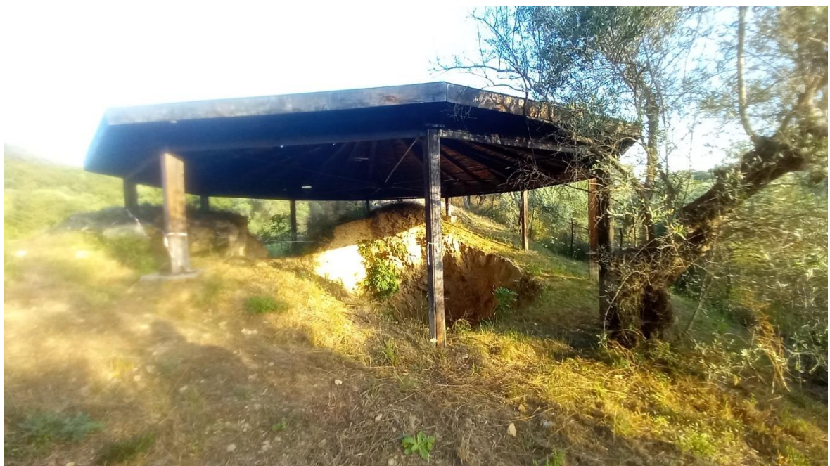
Εικ. 2.: Άποψη του στεγαστρου από τα νότια.
