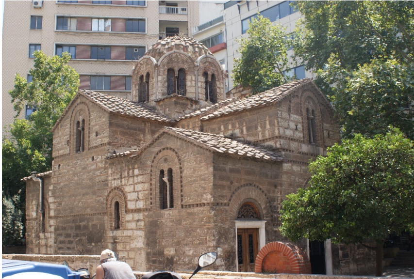
Φωτ. 2 Όψη στεγών από την Βορειοδυτική πλευρά του ναού
