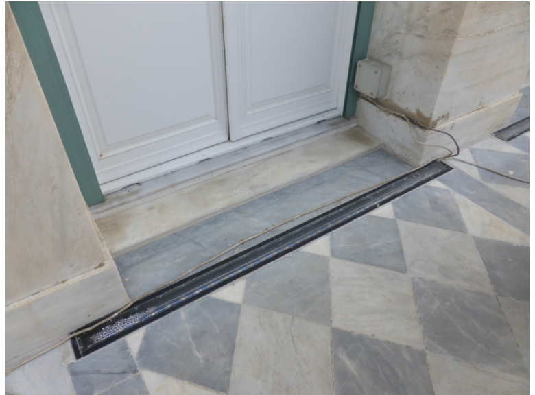
Εικ. 13. Ενδοδαπέδιο φωτιστικό στον ανατολικό εξώστη.
