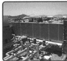
ΕΦΑΡΜΟΓΗ ΣΕ ΗΧΟΜΟΝΩΣΗ ΜΗΧΑΝΟΛΟΓΙΚΟΥ ΔΩΜΑΤΟΣ
